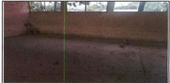
Pintura en muros exteriores e interiores
