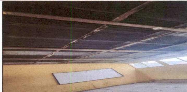
sustitución de estructura de soporte de madera, por metal
