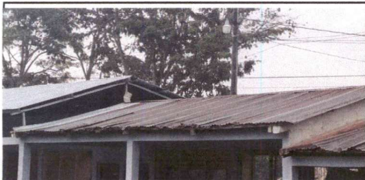
sustitución de lamina, por lamina troquelada aluzic calibre 26
