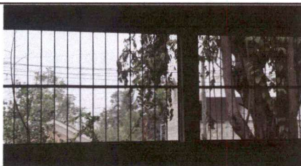
sustitucio de balcones de metal
