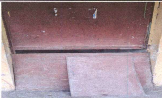
Sustitucion de puertas de metal
