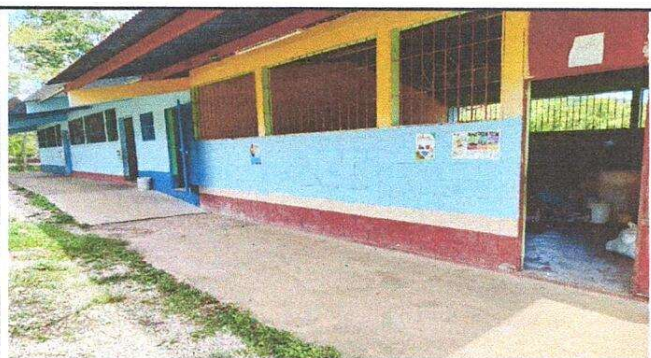
PINTURA EN MUROS EXTERIORES 9.1
