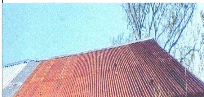
1.2 SUSTITUCION DE CAPOTE DE LAMINA, PARA LAMINA TROQUELADA
