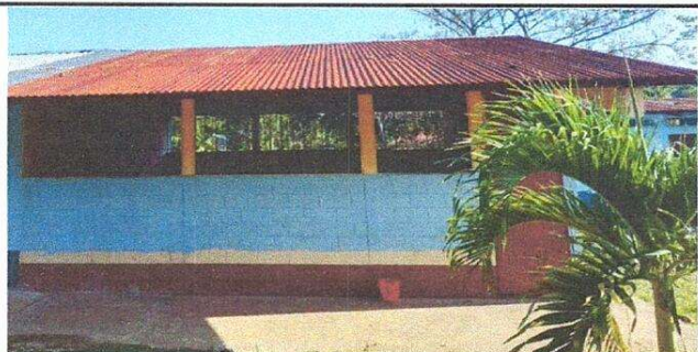
FOTO 1. SUSTITUCION DE LAMINA, POR LAMINA TROQUELADA ALIZIN CALIBR 26 1.1
