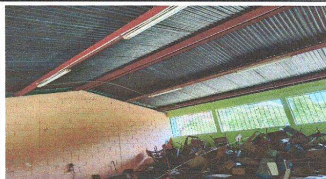
MANTENIMIENTO DE ESTRUCTURA DE SOPORTE DE METAL 2.1
