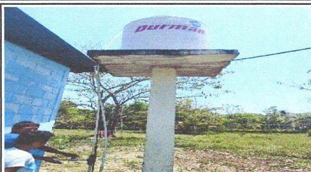
SUSTITUCION DE DEPOSITO DE AGUA DE 1,700 LITROS 18.3
