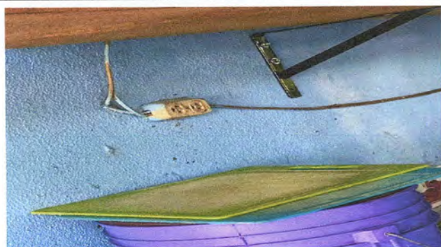
FOTO 5 SUSTITUCION DE TOMACORRIENTES DOBLES
