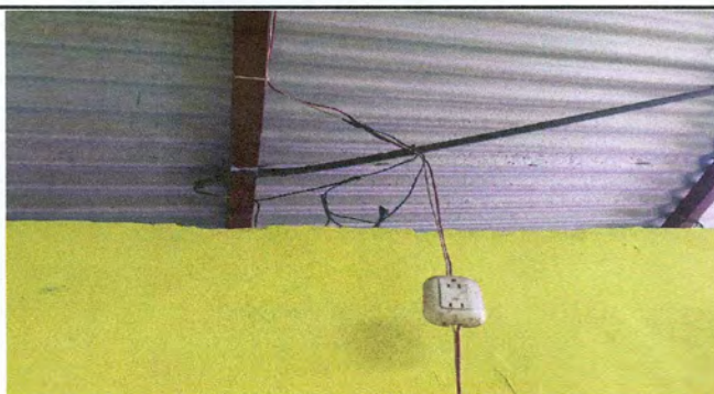
FOTO 9. REPARACION DE CABLEADO ELECTRICO
