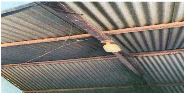
FOTO 7. SUSTITUCION DE PLAFONERA
