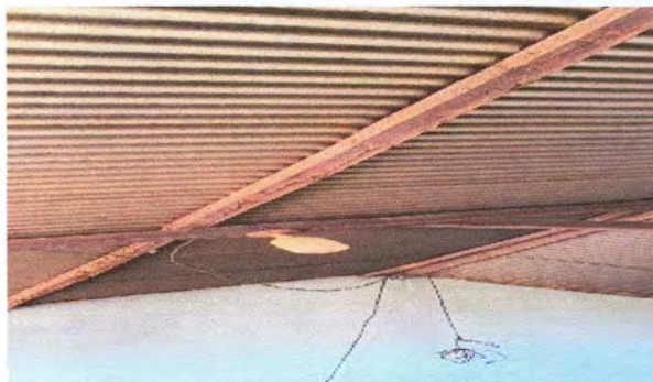
FOTO 8 SUSTITUCION DE FOCOS AHORRADORES
