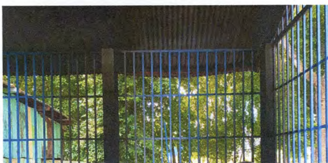
FOTO 3 SUSTITUCION DE BALCONES DE METAL
