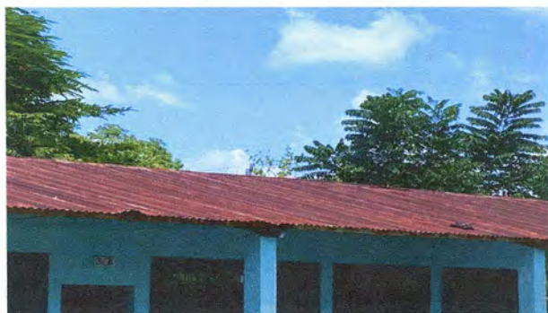
FOTO 1. SSTITUCION DE LÁMINA, POR LAMINA TROQUELADA ALUZING CALIBRE 26
