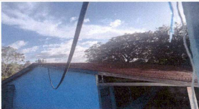
REPARACION DEL CABLEADO ELECTRICO
