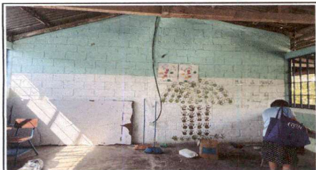
PINTURA EN MUROS EXTERIOR E INTERIOR
