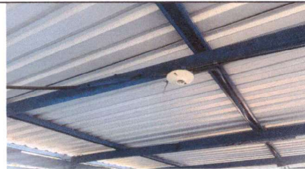
SUSTITUCION DE PLAFONERAS
