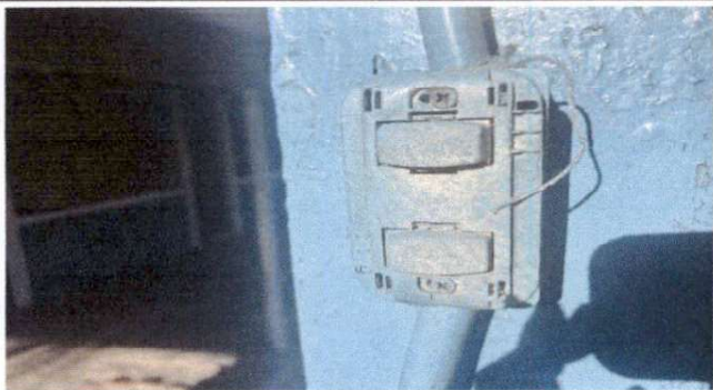
SUSTITUCION DE INTERRUPTOR DOBLE
