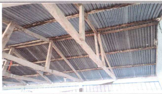
SUSTITUCION DE SOPORTE DE MADERA ,POR METAL
