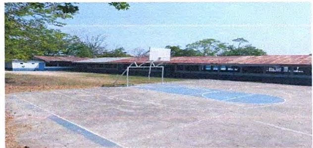
Foto 4: SUSTITUCIÓN DE LAMINA, POR LAMINA TROQUELADA ALUZINC CALIBRE 26
