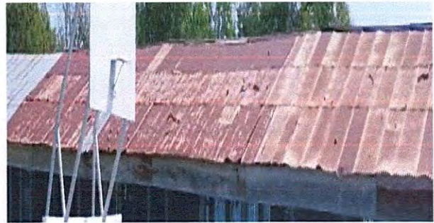
Foto 2: SUSTITUCION DE CAPOTE
