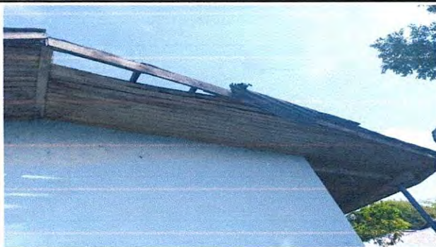
FOTO 3. SUSTITUCION DE ESTRUCTURA DE SOPORTE DE MADERA, POR METAL
