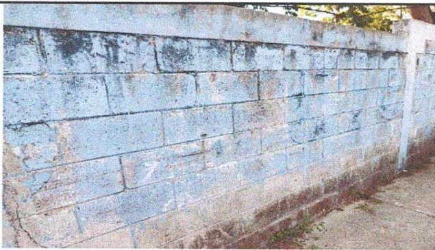
FOTO 3. PINTURA EN MUROS EXTERIORES E INTERIORES
