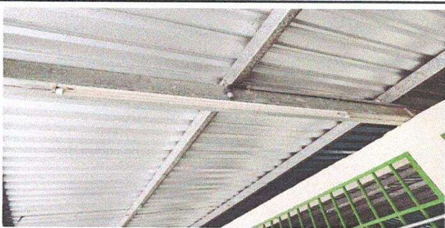
FOTO 5. SUSTITUCION DE FOCOS AHORRADORES
