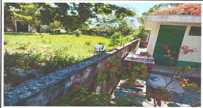
FOTO 4 REPARACION DE MURO PERRIMETRAL DE BLOCK
