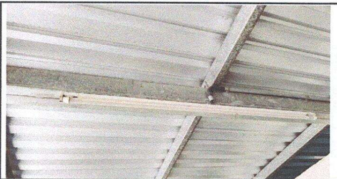
FOTO 6. SUSTITUCION DE PLAFONERAS
