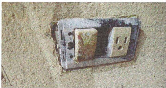
FOTO 7. SUSTITUCION DE INTERRUPTOR DOBLE
