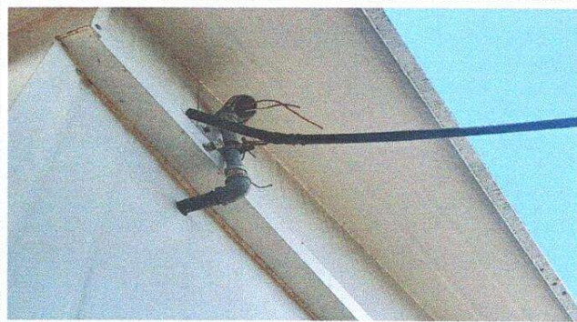
FOTO 8. REPARACION DE CABLEADO ELÉCTRICO
