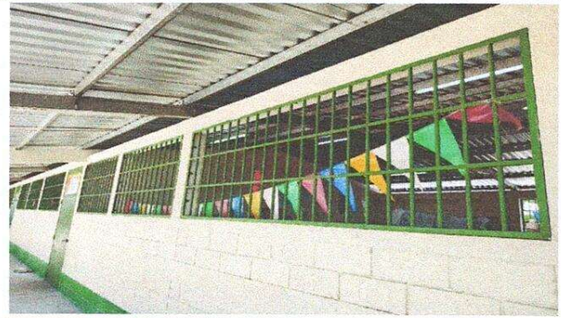
FOTO 2. MANTENIMIENTO A BALCONES DE METAL
