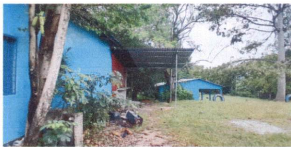
Foto 2: Sustrucción de lamina por lamina troquelada Alucinc calibre 26
