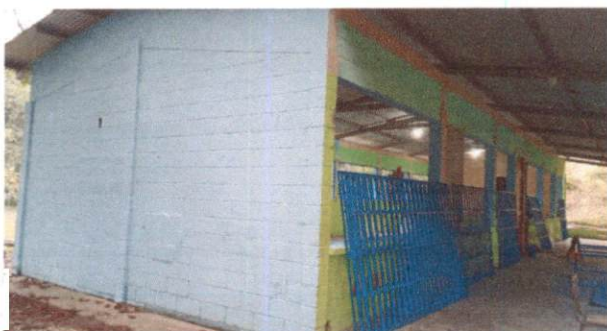
Foto 1: Sustrucción de balcones de metal
