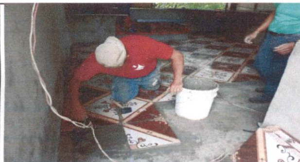
Foto 3: Suministro de piso cerámico
