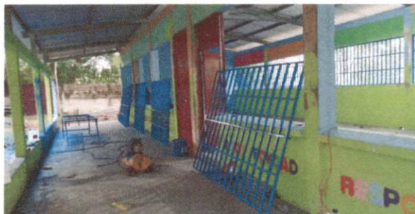
Foto 2: Sustrucción de balcones de metal
