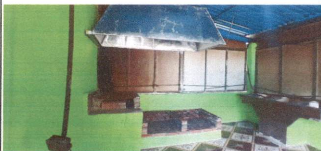
Foto 4: Pintura en muros exteriores e interiores
