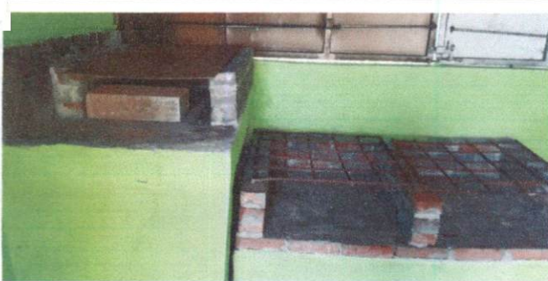
Foto 5: Sustrucción de estufa rural
