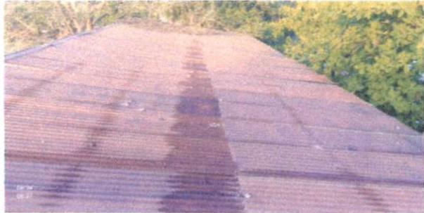
Foto 2: Sustitución de lamina por lamina troquelada Alucinc calibre 26
