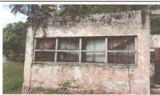
Foto 2: Repello en muro
