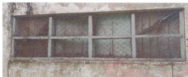
Foto 4: Sustrucción de balcones de metal
