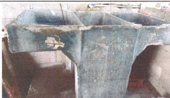
Foto 1: Sustrucción de pila de cemento de dos lavadero
