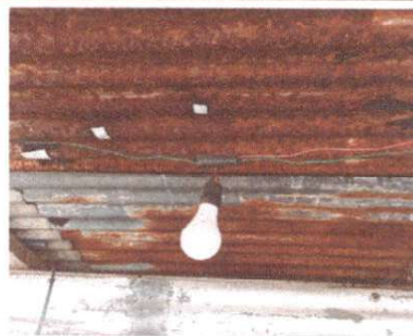
Foto 6: Instalación de Unidades de Luz
