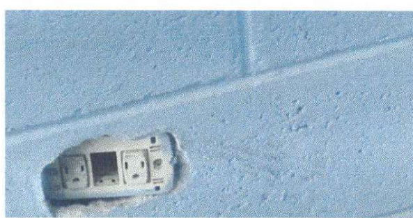
Foto 4: Sustrucción de tomacorrientes dobles
