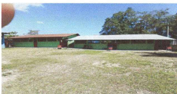
Foto 3: Pintura en muros exteriores e interiores
