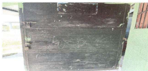
Foto 5: Mantenimiento de estructura
