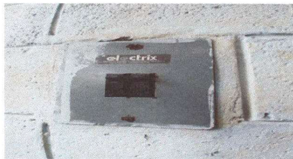
Foto 2: Sustrucción de ductos electricos + accesorios
