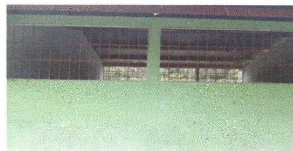
Foto 6: Mantenimiento a balcones de metal
