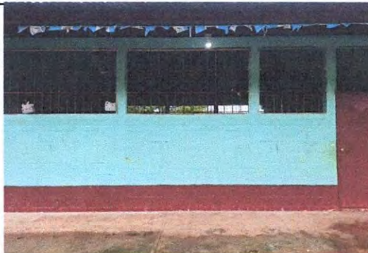
Mantenimiento a balcones de metal
