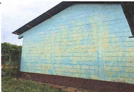
pintura en muros exteriores e interiores
