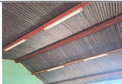
Mantenimiento a estructura de soporte de metal
