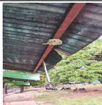
Cambio de tendido eléctrico, plafoneras y focos.
