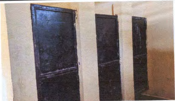
Foto 4: Mantenimiento a estructura (lijado, cambio de tubo, cepillado, sujeciones, aplicación de pintura)
