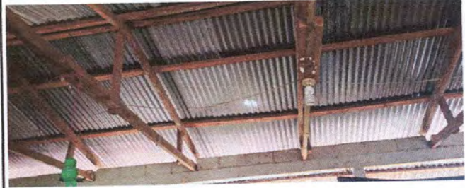
Foto 2: Sustrucción de estructura de soporte de madera, por metal
