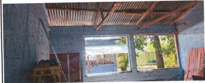
Foto 6: Pintura en muros
