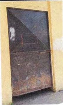
Foto 1: Sustrucción de lámina, por lámina troquelada aluzinc calibre 26
