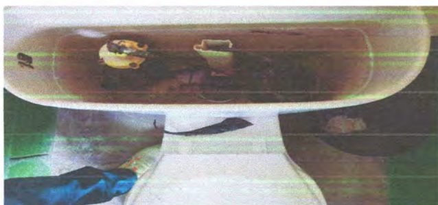
FOTO 5. SUSTITUCION DE ACCESORIOS PARA INODORO (contrallave, tubo de abasto tanque )
