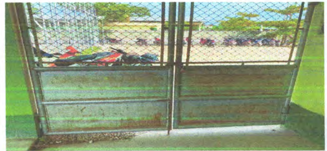
FOTO 10. MANTENIMIENTO A PORTONES DE METAL
