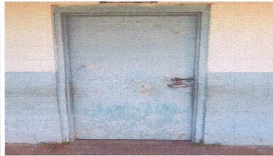
Mantenimiento de Estructura (lijado, cambio de tubo, cepillado, sujeciones, aplicación de pintura)
