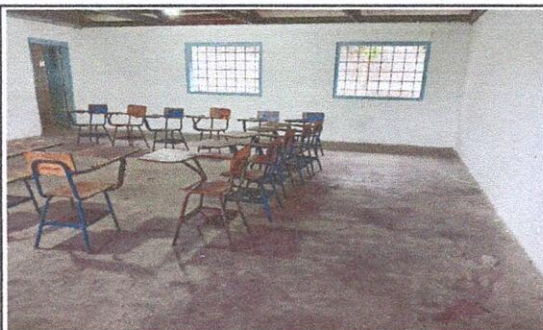
Mejoramiento de Torta de Piso
