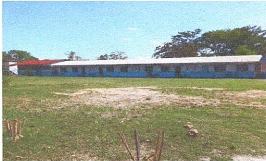
Mejoramiento de Canales y Bajada de Agua Pluvial
