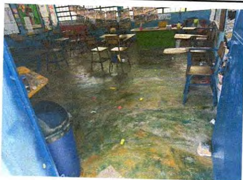
Foto 5: Mejoramiento de piso liso por piso ceramico
