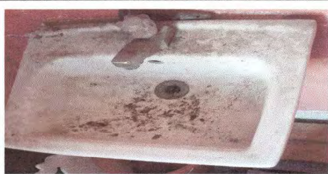
FOTO 4. SUSTITUCION DE LAVAMANOS
