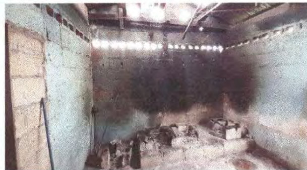
PINTURA EN MURO EXTERIOR E INTERIOR
