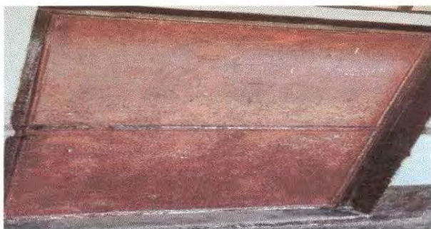
FOTO 5. MANTENIMIENTO A ESTRUCTURA (lijado, cambio de tubo, cepillado, sujeciones y aplicación de pintura.
