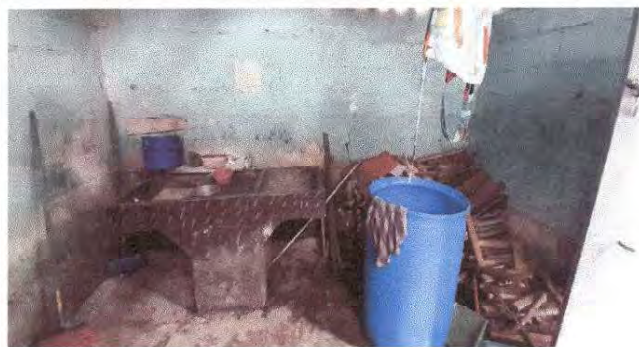
FOTO 9. REPELLO EN MURO
