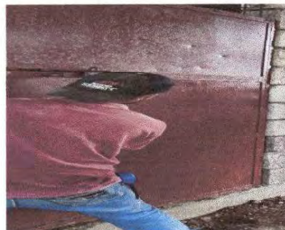
FOTO 8. MANTENIMIENTO A PORTON DE METAL
