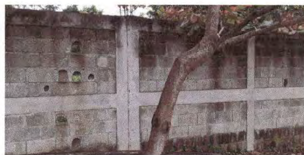
FOTO 12. REPARACION DE MURO PERIMETRAL
