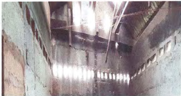
FOTO 13. REPARACIÓN DE CABLEADO ELECTRICO
