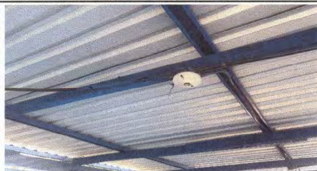
FOTO 10. SUSTITUCION DE PLAFONERAS
