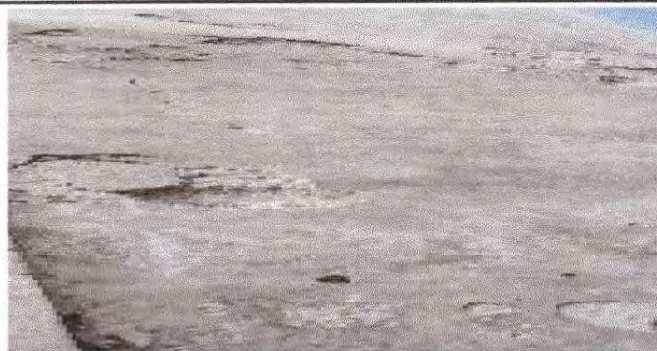
FOTO 1. REPARACION DE PISO DE TORTA DE CONCRETO
