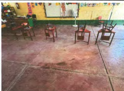
Foto 3: MANO DE OBRA ESPECIALIZADA: Mano de obra de albañilería (picado de piso existente e instalado de piso cerámico)
