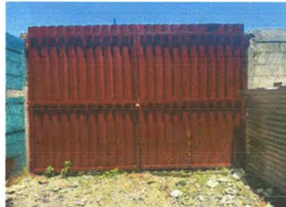
Foto 2: MANTENIMIENTO A PORTÓN: fabricación e instalación de portón de metal de ingreso.
