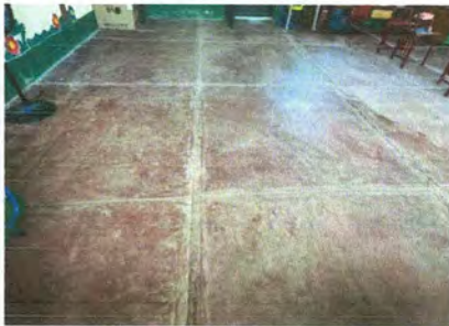
Foto1: PISO: Mejoramiento de piso liso por piso cerámico.
