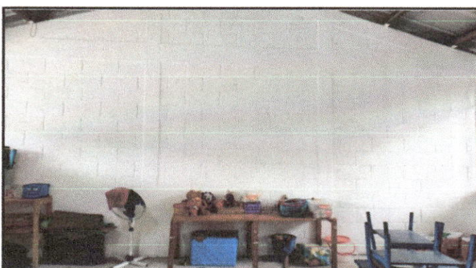
Foto 4: Pintura de muros interiores y exteriores
