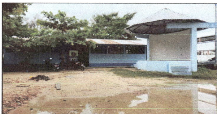
Foto 5: Pintura de muros interiores y exteriores
