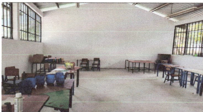
Foto 3: Sustitución de piso de torta de concreto
