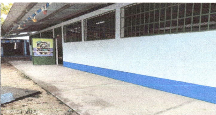
Foto 6: Pintura de muros interiores y exteriores
