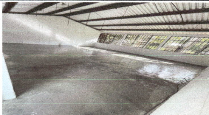
Foto1: Sustitución de piso de torta de concreto
