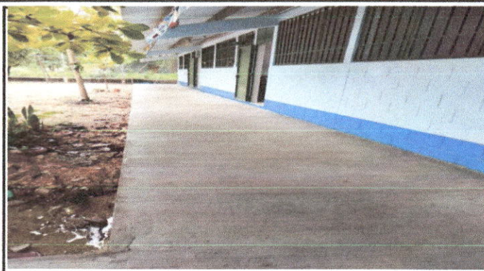
Foto 2:Sustitución de piso de torta de concreto
