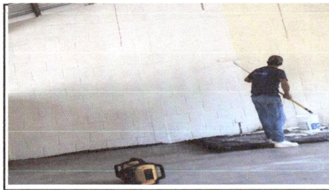
Foto 4: Pintura de muros interiores y exteriores
