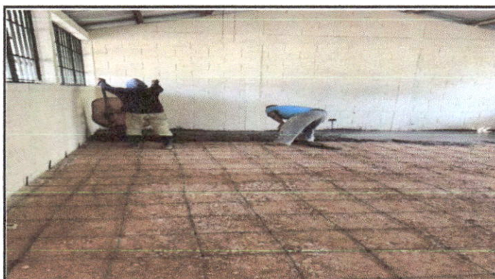
Foto 3: Sustitución de piso de torta de concreto
