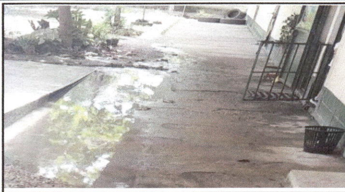
Foto 2:Sustitución de piso de torta de concreto
