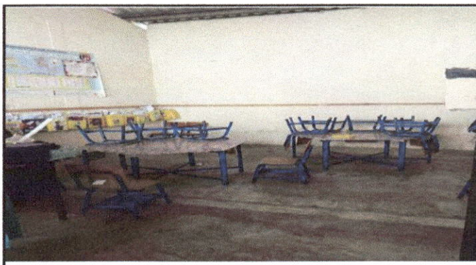
Foto 4: Pintura de muros interiores y exteriores
