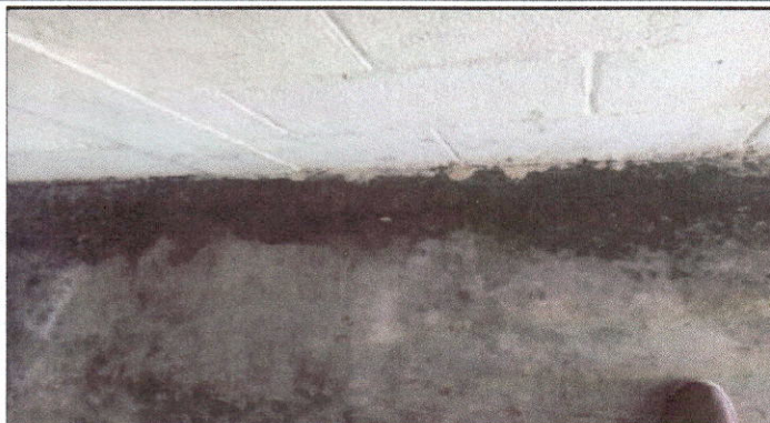
Foto1: Sustitución de piso de torta de concreto
