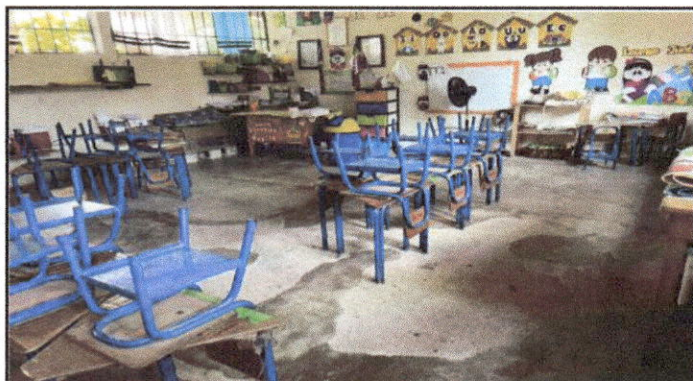
Foto 3: Sustitución de piso de torta de concreto
