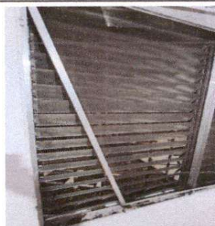
Foto 4: MANTENIMIENTO A MARCOS DE ALUMINIO MIL FINISH ✓
