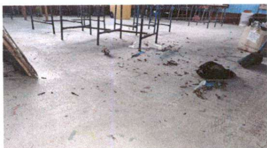
Foto 1: SUSTITUCIÓN DE PISO DE CEMENTO LÍQUIDO ✓
