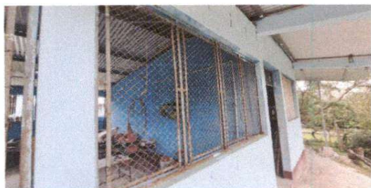
Foto 3: SUSTITUCIÓN DE BALCONES DE METAL
