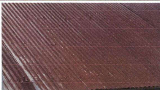
Foto 8: SUSTITUCIÓN DE LÁMINA, POR LÁMINA TROQUELADA ALUZINC CALIBRE 26
