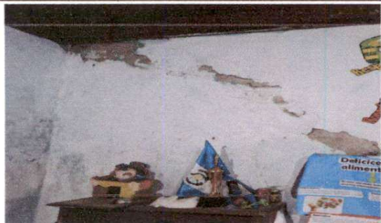
Foto 7: REPELLO EN MUROS Y CERNIDO DE PAREDES
