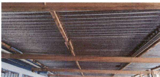
Foto : 9 SUSTITUCIÓN DE ESTRUCTURA DE SOPORTE DE MADERA, POR METAL
