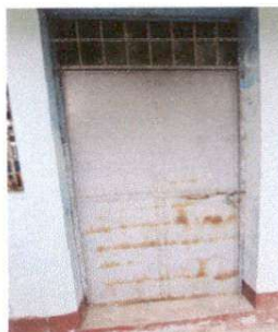
Foto 2: SUSTITUCIÓN DE PUERTA ✓
