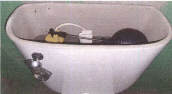
Foto 3: SUSTITUCIÓN DE ACCESORIOS PARA INODORO (CONTRA LLAVE, TUBO DE ABASTO Y MANGUERA)
