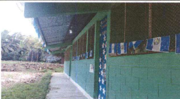
Foto 5: PINTURA EN MUROS EXTERIORES E INTERIORES
