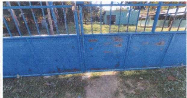
Foto 2: MANTENIMIENTO A PORTONES DE METAL
