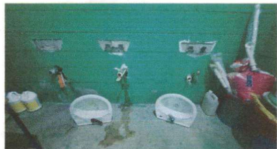
Foto 4: INSTALACION DE LAVAMANOS Y ACCESORIOS CON BASE DE CONCRETO
