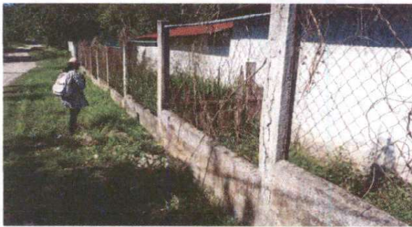
Foto 1: REPARACIÓN DE MURO PERIMETRAL DE BLOCK, TUBO HG Y MALLA GALVANIZADA
