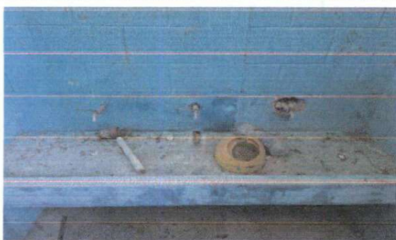
Foto 5: SUSTITUCIÓN DE GRIFOS
