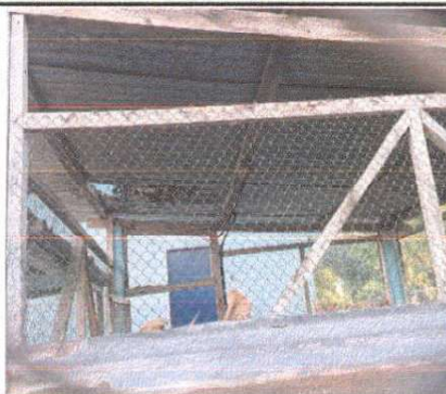
Foto 8: SUSTITUCIÓN DE LÁMINA, POR LÁMINA TROQUELADA ALUZINC CALIBRE 26
