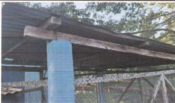
Foto 9: SUSTITUCIÓN DE ESTRUCTURA DE SOPORTE DE MADERA, POR METAL
