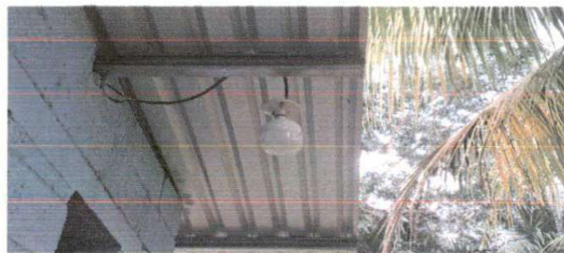
Foto 6: SUSTITUCIÓN DE FOCOS AHORRADORES
