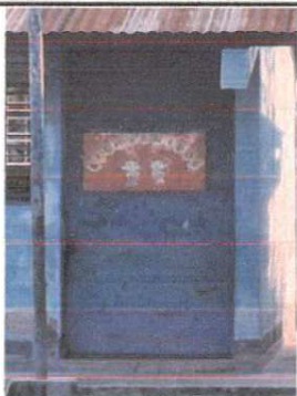
Foto 1: SUSTITUCIÓN DE PUERTA ✓
