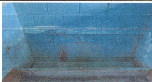
Foto 10: SUSTITUCIÓN DE LLAVE EN MIGITORIO
