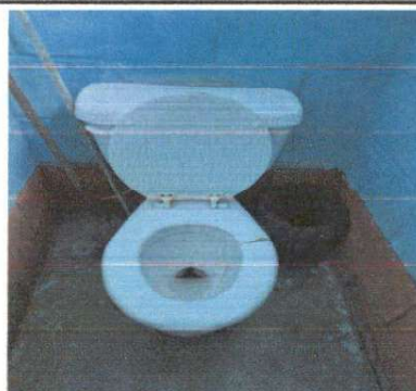
Foto 4: SUSTITUCIÓN DE INODORO
