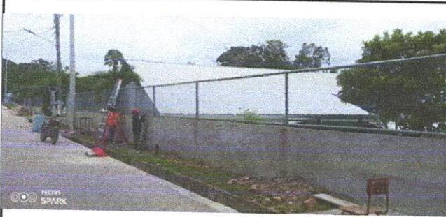
Foto 7: Muro perimetral principal
