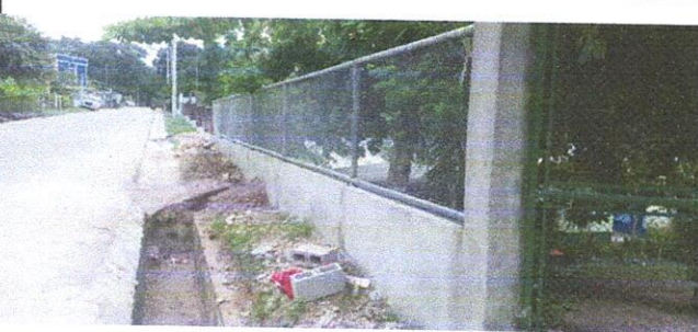
Foto 9: Muro perimetral de block
