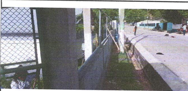
Foto 10: Muro perimetral de malla galvanizada
