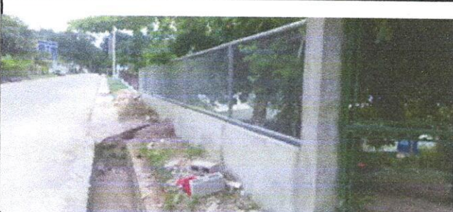
Foto 4: Reparación de muro perimetral de block
