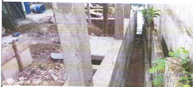
Foto 1: Reparacion de cuneta
