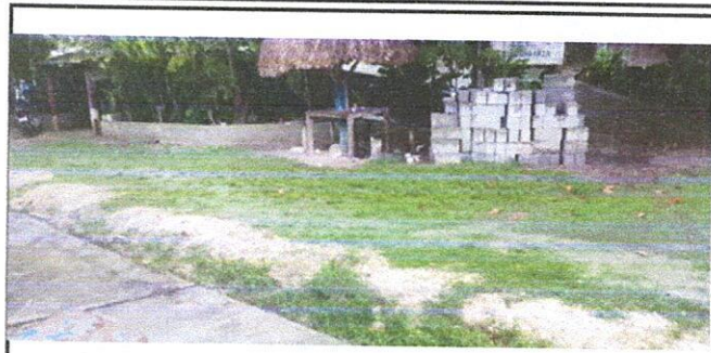
Foto 8: Banqueta de concreto
