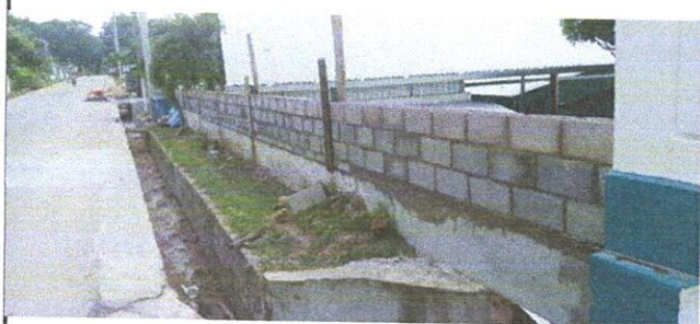
Muro perimetral de block
