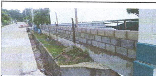
Foto 2: Sustitución de baqueta de piedra por blok
