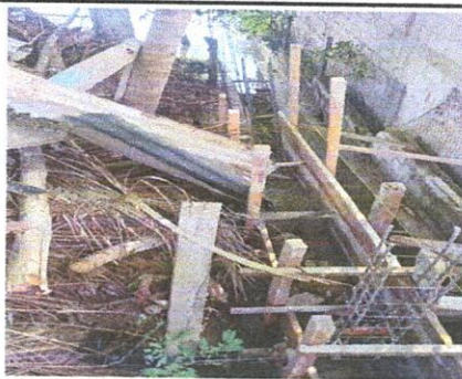
Foto 5: Reparación de muro de contención
