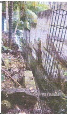
Foto 3: Reparación de reposadera
