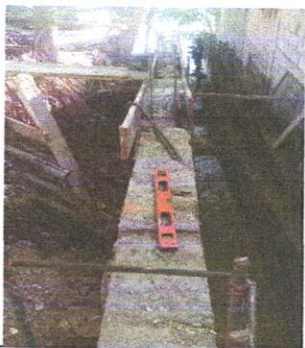
Foto 1: Reparación de cuneta
