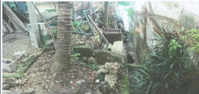
Foto 8: Reparacion de muro de contencion
