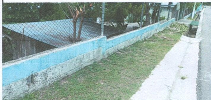
Foto 4: Reparación de muro perimetral de block
