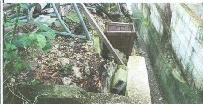
Foto 3: Reparacion de reposadera
