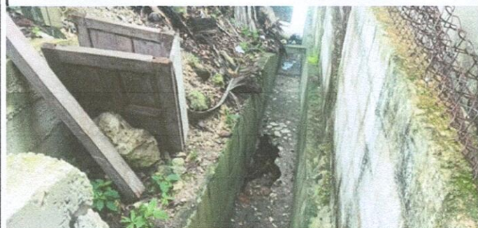
Foto 1: Reparacion de cuneta
