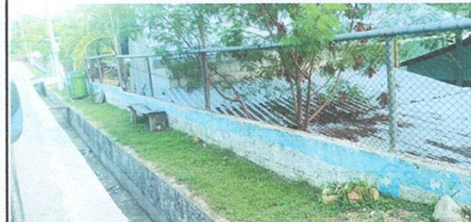
Foto 6: Reparación de muro perimetral de block con tubo hg y malla galvanizada.
