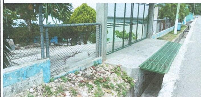
Foto 5: Cambio reparacion y ampliacion de tubo hg y malla galvanizada en muro perimetral.
