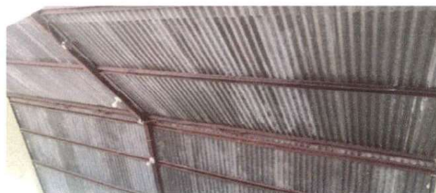
2.2 Sustitución de estructura de soporte de madera, por metal ✓
