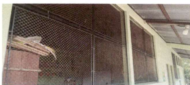
5.6 Sustitución de balcones de metal ✓
