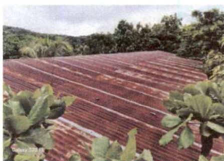
1.1 Sustitución de lámina, por lámina troquelada aluzinc calibre 26 ✓
