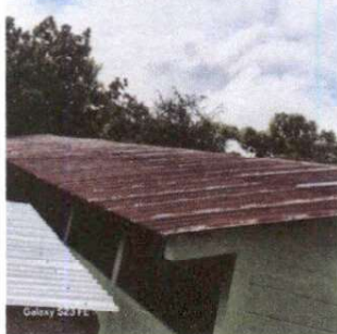
19.8 Instalación de lámina troquelada aluzinc
