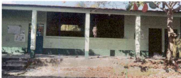
9.1 Pintura en muros exteriores e interiores ✓
