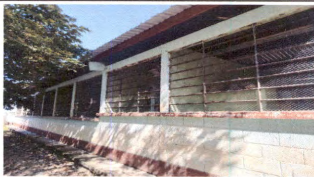
SUSTITUCION DE BALCONES DE METAL
