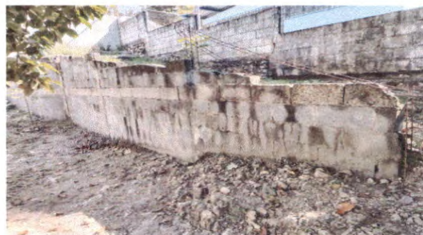
REPARACION DE MURO PERIMETRAL DE BLOCK
