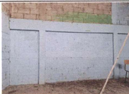
Foto 8: Sellado de grietas y fisuras en muros.
