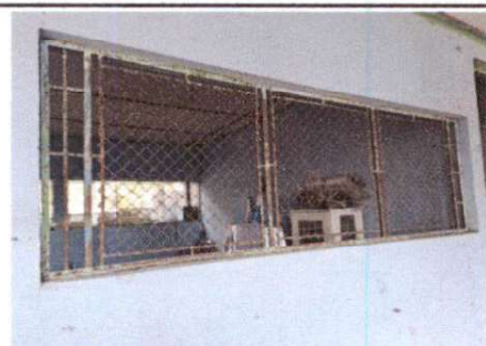
Foto 5: Sustitución de barandas de metal
