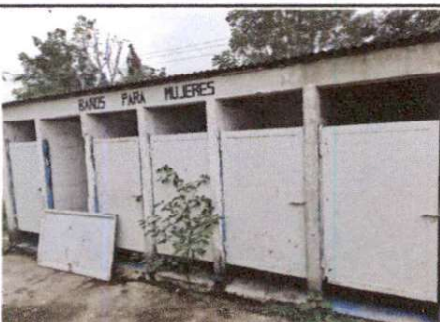
Foto 3: Sustitución de puertas en servicios sanitarios.
