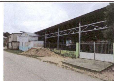
Foto 6: Mantenimiento a portones de metal
