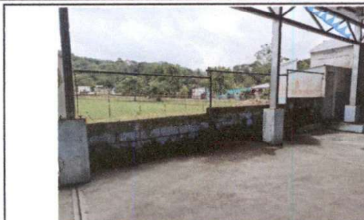
Foto 7: Reparación de muro perimetral de block con tuvo hg y malla galvanizada, soleras intermedias y columnas.
