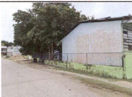
Foto 4: Pintura en muros exteriores e interiores
