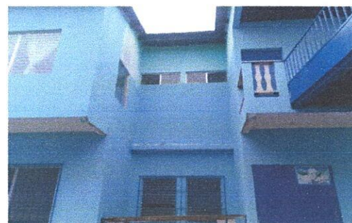
Foto 6: PINTURA DE MUROS EXTERIORES E INTERIORES
