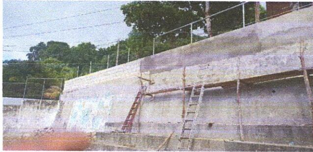
Foto 1: REPARACION DE MURO PERIMETRAL DE BLOCK, TUBO HG Y MALLA GALVANIZADA
