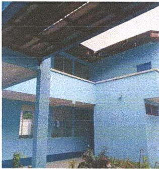
Foto 3: SUSTITUCION DE VIDRIO PRIMER NIVEL, SEGUNDO NIVEL
