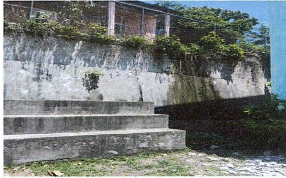
Foto 2: REPARACIÓN DE MURO PERIMETRAL DE BLOCK, TUBO HG Y MALLA GALVANIZADA.
