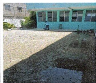
Foto 5: CREACIÓN DE CUNETAS DE CONCRETO.
