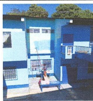
Foto 6: PINTURA DE MUROS EXTERIORES E INTERIORES
