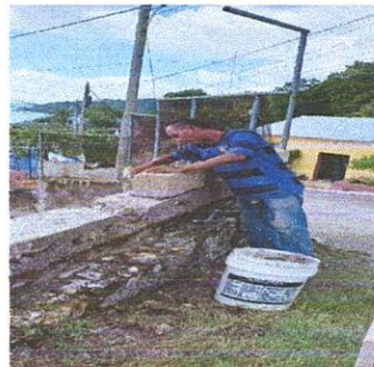
Foto 2: REPARACION DE MURO PERIMETRAL DE BLOCK, TUBO HG Y MALLA GALVANIZADA
