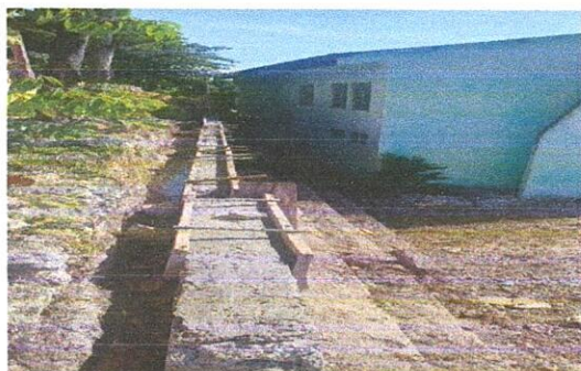
Foto 1: REPARACION DE MURO PERIMETRAL DE BLOCK, TUBO HG Y MALLA GALVANIZADA
