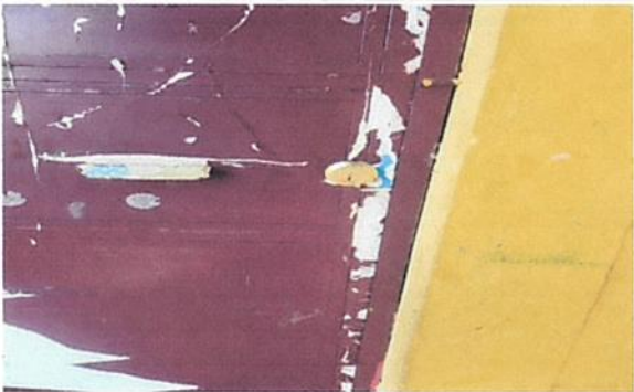
Foto 3: Sustitución de Chapas.
