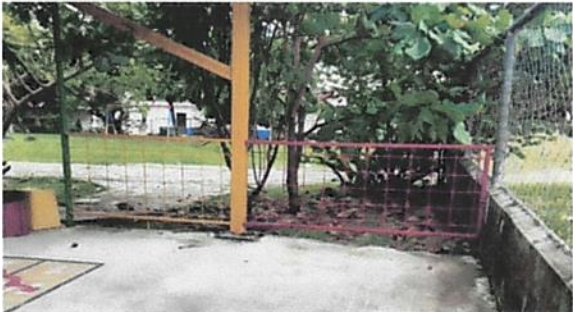
Foto 5: Mantenimiento a barandales
