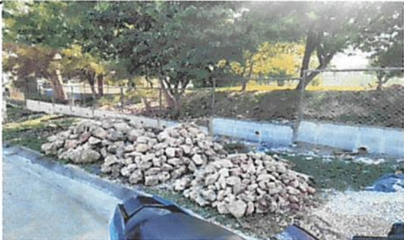
Foto 6: Mantenimiento a muro perimetral.
