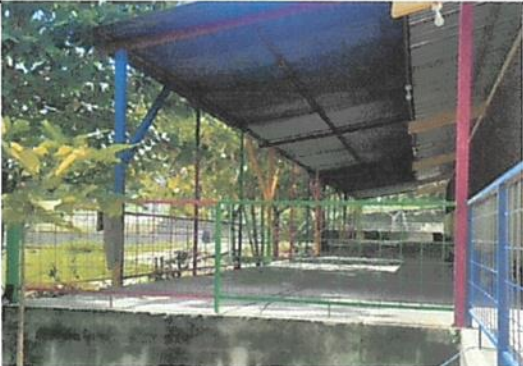
Foto 4: Mantenimiento a barandales.
