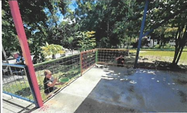
Foto 4: Mantenimiento a barandales.
