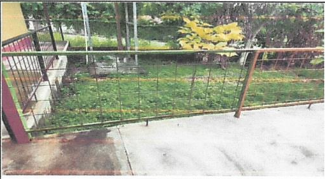
Foto 4: Mantenimiento a barandales.
