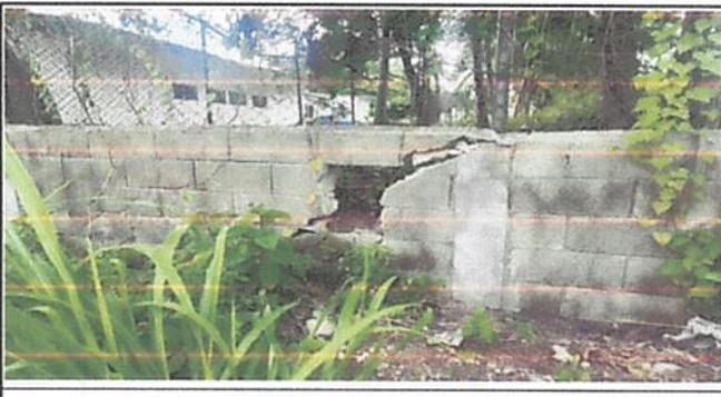
Foto 6: Mantenimiento a muro perimetral
