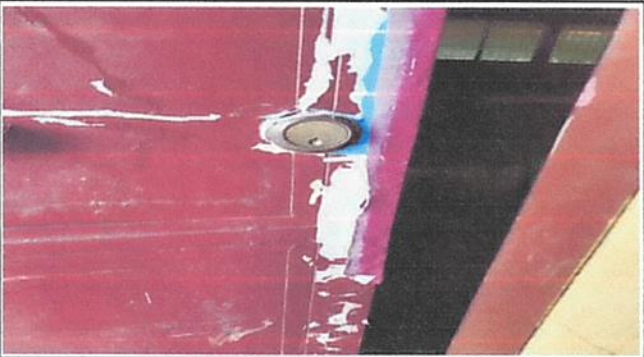
Foto 3: Sustrucción de Chapas.
