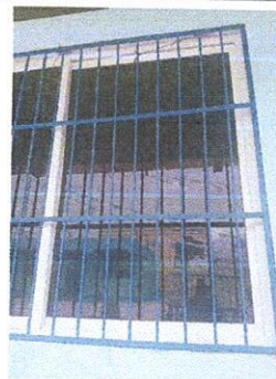
Foto 4: MEJORAMIENTO DE VENTANAS DE VIDRIO POR VENTANAS DE PVC
