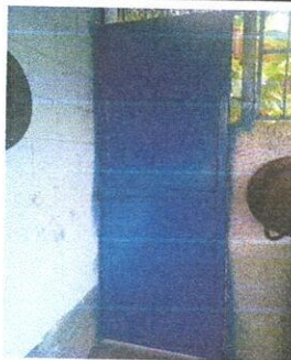
Foto 5: SUSTITUCION DE PUERTAS
