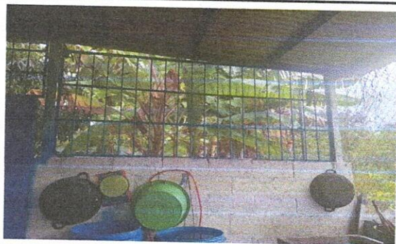
Foto 3: FABRICACION E INSTALACION DE BALCONES
