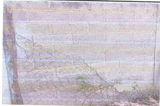
Foto 1: REPARACION DE MURO DE BLOCK
