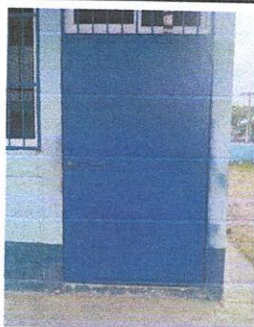
Foto 5: SUSTITUCION DE PUERTAS
