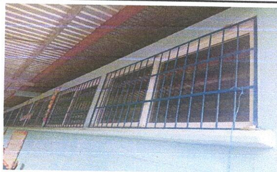
Foto 4: MEJORAMIENTO DE VENTANAS DE VIDRIO POR VENTANAS DE PVC
