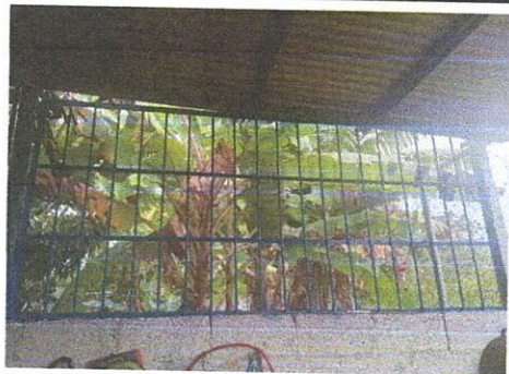
Foto 3: FABRICACION E INSTALACION DE BALCONES
