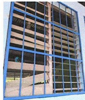
Foto 4: Mejoramiento de ventanas de vidrio por ventanas PVC.
