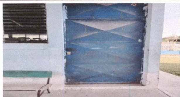
FOTO 3: MANTENIMIENTO A ESTRUCTURA, LIJADO, SEPILLADO Y PULIDO
