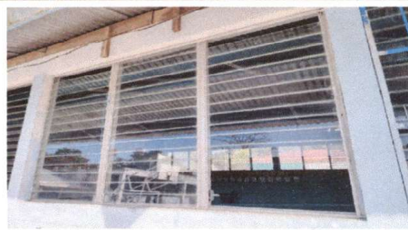
FOTO 4: SUSTITUCION DE VIDRIO
