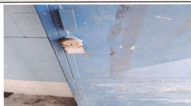
FOTO 2: SUSTITUCION DE CHAPAS
