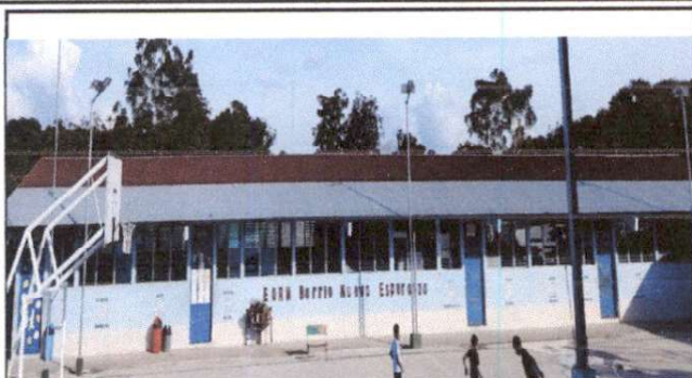
FOTO 1: PINTURA EN MUROS EXTERIORES E INTERIORES
