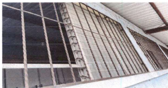
FOTO 5: SUSTITUCION DE BALCON DE METAL
