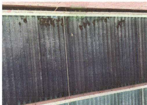
Foto 3: Sustrucion de lamina por lamina troquelad aluzinc calibre 26
