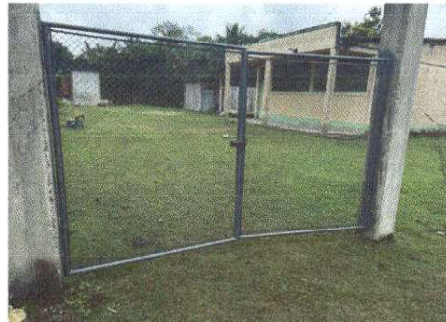
Foto 6: Mantenimiento a porton de metal
