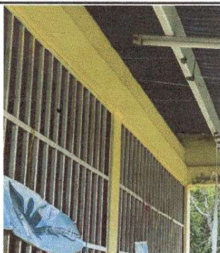
Foto 9: Mantenimiento a estructuras de metal de valcones
