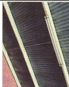
Foto 8: Mantenimiento a estructura de soporte de metal
