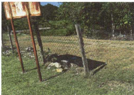
Foto 7: Reparación de tubo hg y malla galvanizada
