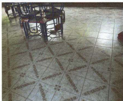
Foto1: Sustrucion de piso ceramico
