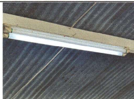
Foto 4: Sustrucion de lamparas Led
