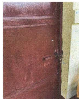
Foto 2: Mantenimiento a estructuras ( lijado, cambio de tubo, cepillado, sujeccion, aplicacion de pintura)
