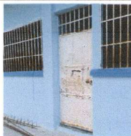
Sustitución de chapa ✓
