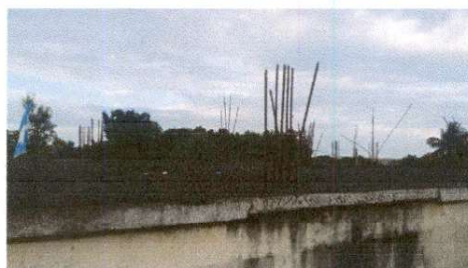
Impermeabilización de losa ✓
