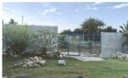
Pintura en muros exteriores e interiores
