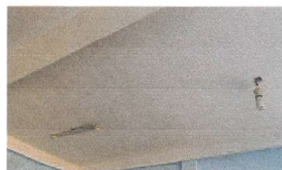
Instalación de unidades luz (incluye interruptor, ducto y cable eléctrico) ✓
