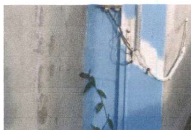
Instalación de unidades fuerza (tomacorriente), incluye cable eléctrico
