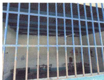
FOTO 4: MANTENIMIENTO A BALCONES DE METAL LIJADO Y PINTADO ✓
