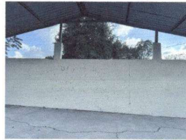
FOTO 1: PINTURA DE INTERIORES Y EXTERIORES
