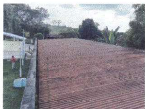
FOTO 1: SUSTITUCION DE LAMINA POR LAMINA TROQUELADA CALIBRE 26 ✓
