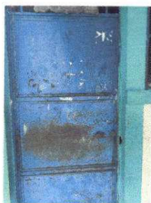
FOTO 5: MANTENIMIENTO A ESTRUCTURA (LIJADO, APLICACIÓN DE PINTURA) ✓
