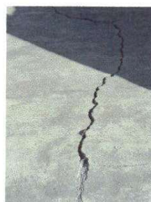
FOTO 6: SUSTITUCION DE TORTA DE PISO POR TORTA DE PISO
