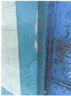
FOTO 1: REPELLO DE MUROS DE CONCRETO
