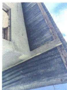
FOTO 2: SUSTITUCION DE SOPORTE DE MADERA POR METAL ✓
