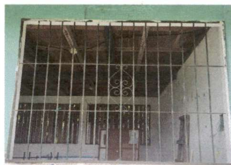
Foto 4: Mantenimiento a balcones de Metal
