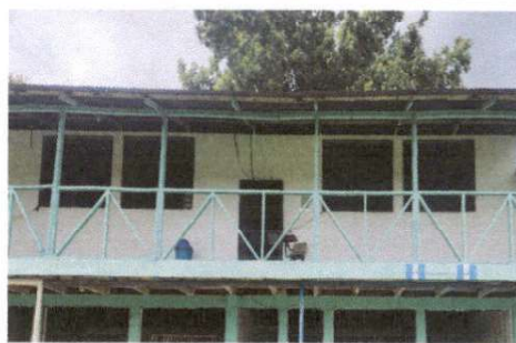
Foto 6: Pintura en muros exteriores e interiores.
