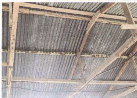
Foto 5: Sustrucción de lámina, por lámina troquelada aluzinc calibre 26
