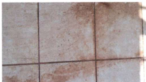
Foto 7: Sustitución de piso cerámico
