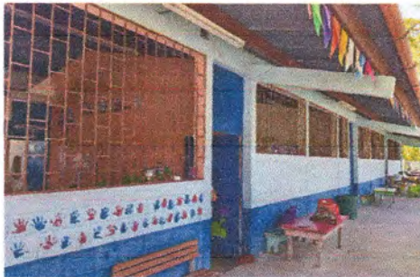
Foto 3: Pintura en muros exteriores e interiores
