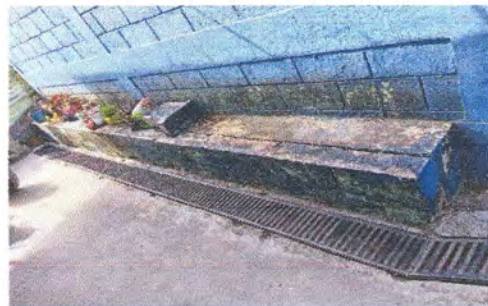
Foto 6: Reparación de banquetas de concreto
