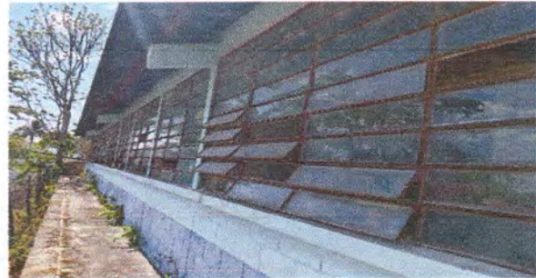
Foto 2: Sustrucción de balcones de metal
