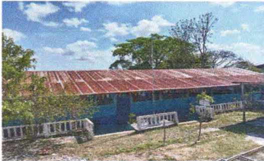
Foto1: Sustrucción de lámina por lámina troquelada de aluzinc calibre 26
