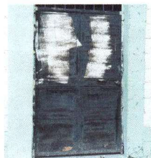
FOTO 4: mantenimiento a estructura (lijado cambio de tubo, cepillado, sujeciones, aplicación de pintura)
