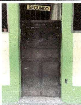
FOTO 3: sustitución de puertas
