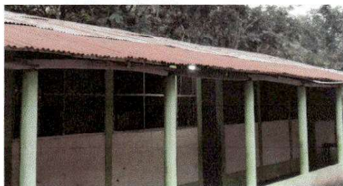
FOTO 1: sustitución e instalación de lamina, por lamina troquelada aluzinc calibre 26
