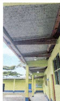
Foto 4: Desistalacion de estructuras portantes
