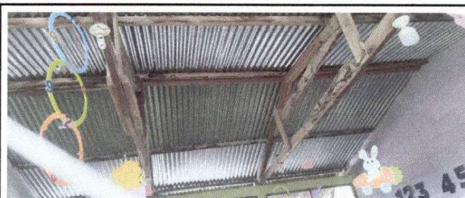
Foto 3:Sustitucion de plafoneras sustitucion de focos ahorradores
