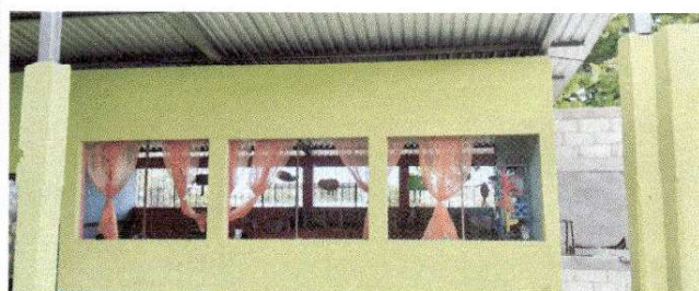
Foto 6: Sustitucion de balcones de metal
