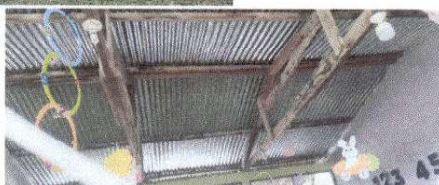
Foto1: Sustitucion de lamina . Por lamina troquelada aluzinc calibre 26
