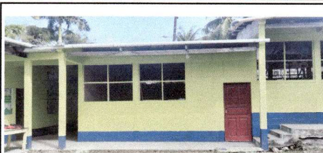
Foto 2: Sustitucion de canales de metal
