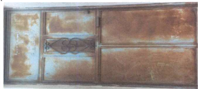
Foto 5: SUSTITUCIÓN DE PUERTADE METAL
