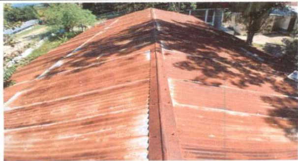
Foto 1: SUSTITUCION DE LAMINA POR LAMINA TROQUELADA ALUZINC CALIBRE 26.1.1
