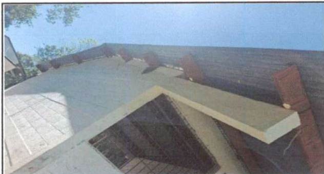
Foto 3: MANTENIMIENTO A ESTRUCTURA DE SOPORTE DE METAL.
