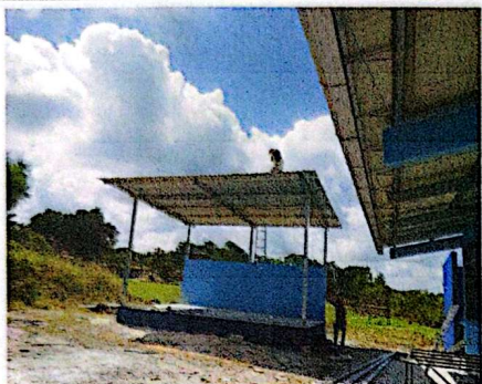
Foto 1: Sustrucion de Lámina
