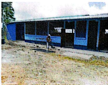
Foto 7: Pintura en muros
