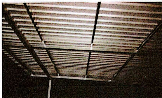
Foto 2: Estructura de soporte de metal
