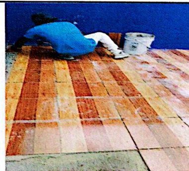
Foto 6: Mejoramiento de piso de torta de concreto a piso cerámico
