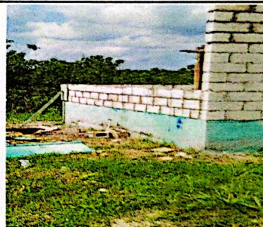
Foto 10: Sellado de grietas y fisura
