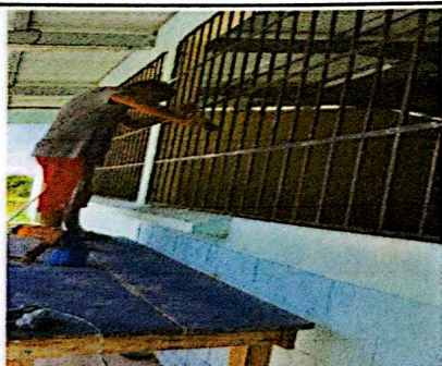
Foto 5: Mantenimiento a balcones
