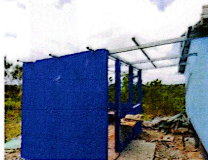
Foto 2: Estructura de soporte de metal
