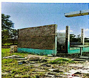
Foto 9: cernido en muros
