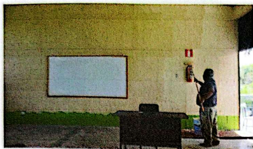
Foto7: Pintura en muros
