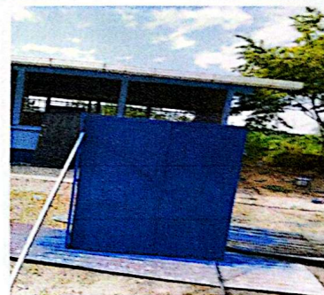
Foto 4: Sustitución de Ventana
