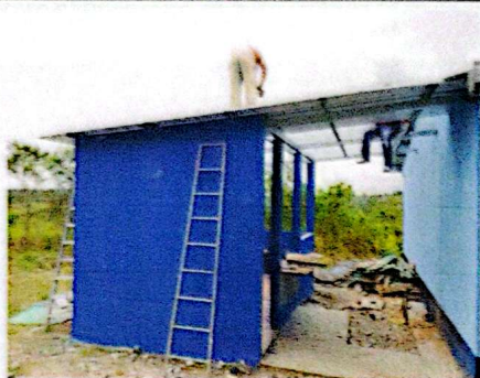
Foto 1: Sustitución de Lámina
